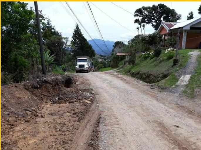
Se trabajó en Calle Calvo ubicada en San Cristóbal Sur, las obras se centraron en la ampliación vial para posteriormente conformar las cunetas y lastrear el camino.
