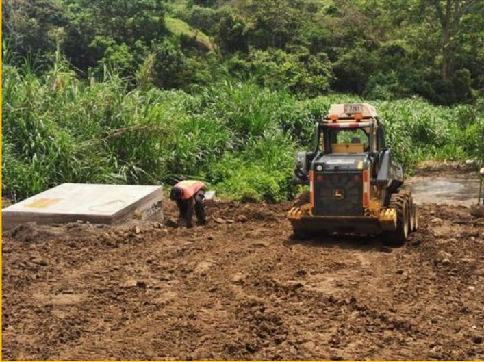
Se finalizó la construcción de las cajas de registro y colocación de tuberías en Barrio San Martín en San Miguel. Se colocaron aproximadamente 18 metros de tubería y 3 cajas de registro.
